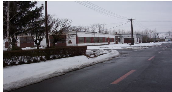
A daraboló és hegesztő csarnok épülete
